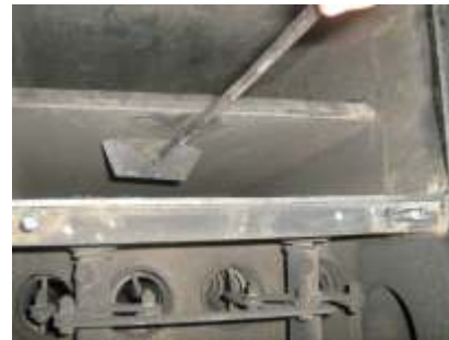
Καθαρίστε τους τοίχους του εναλλάκτη με αναμόχλευση
